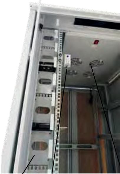
Kabelkanal, Temperatureinheit, Lüfter
